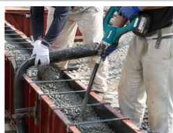
コンクリートバイブレーター
